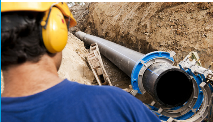
Ledningsbyggandet till Svedala tätort som påbörjades i april 2010 stod klart i januari 2011.
